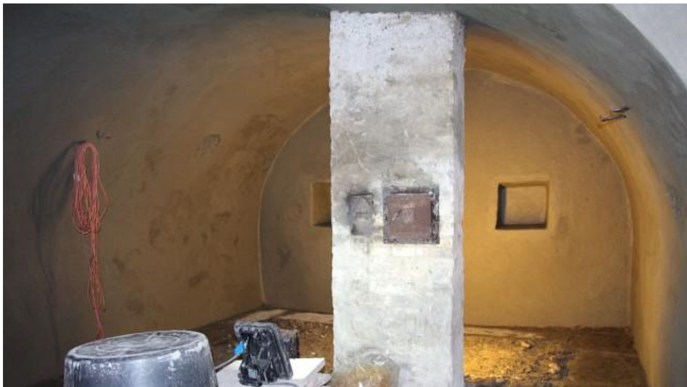
Innsiden av middelalderkjelleren.
